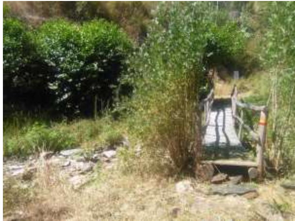
Figura 8: Ponte de madeira
