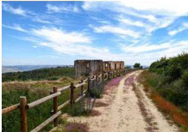
Figura 10: Ecopista do Sabor
