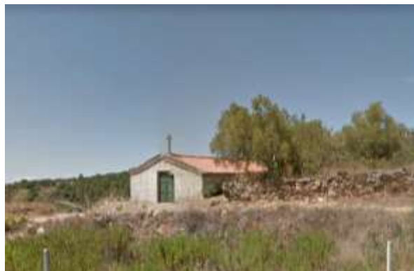
Figura 5: Igreja de Nossa Senhora do Amparo
