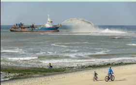
FIGUUR 2.28 De zandhoepzuiger Froewy vertakt de kust bij Wauwan naar zandsuppletie, 2021.
