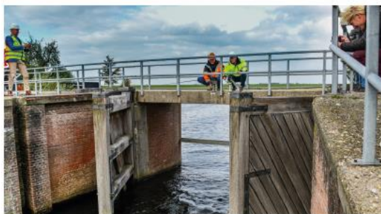
FIGUUR 2.25 Bij de Guldorus Sluis zijn de verouderde sluisdeuren die je op de foto ziet, in 2022 vervangen door geautomatiseerde sluisdeuren.
