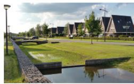
FIGUUR 2.24 Tegenwoordig zie je in nieuwbouwwijken, zoals hier in Venray, vaak laagte: zogenoemde wadi's.
