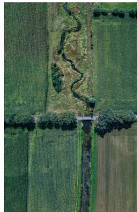
FIGUUR 2.25 In de eerste helft van de jaren 1960 werd de Esche Elzenen bij Boxtel in Noord-Brabant verhard en verdiept en werden de bochten verwijderd. Inmiddels is een groot deel weer in oude luister hersteld. Op de foto is onder het rechtgetrokken deel van de beek te zien en boven het herstelde deel.
