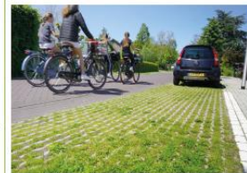
FIGUUR 2.27 Door de grasbetontegels kan water makkelijker infiltreren en worden vastgehouden.
