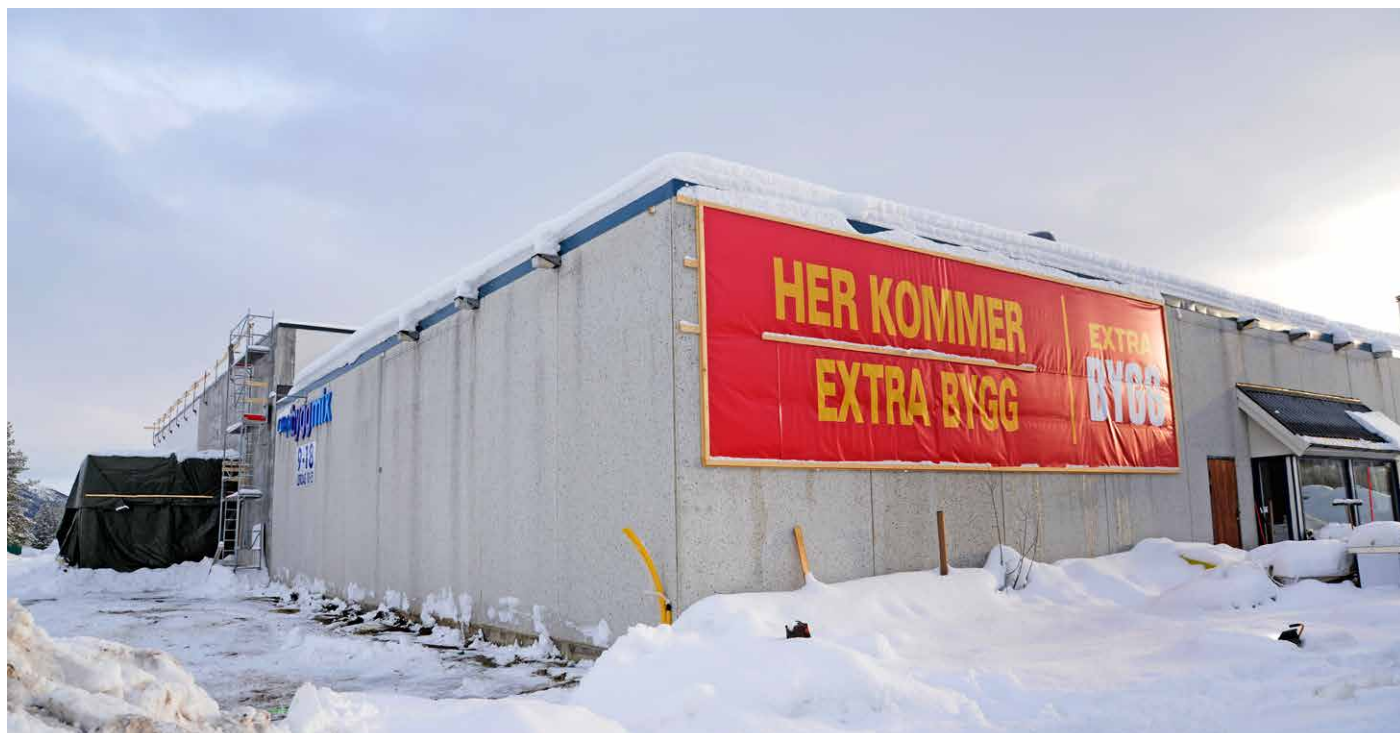
Extra Bygg begynner å ta form på Andslimoen.
