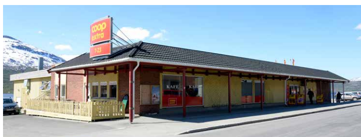
Extra Sjøvegan skal renoveres på sikt.
