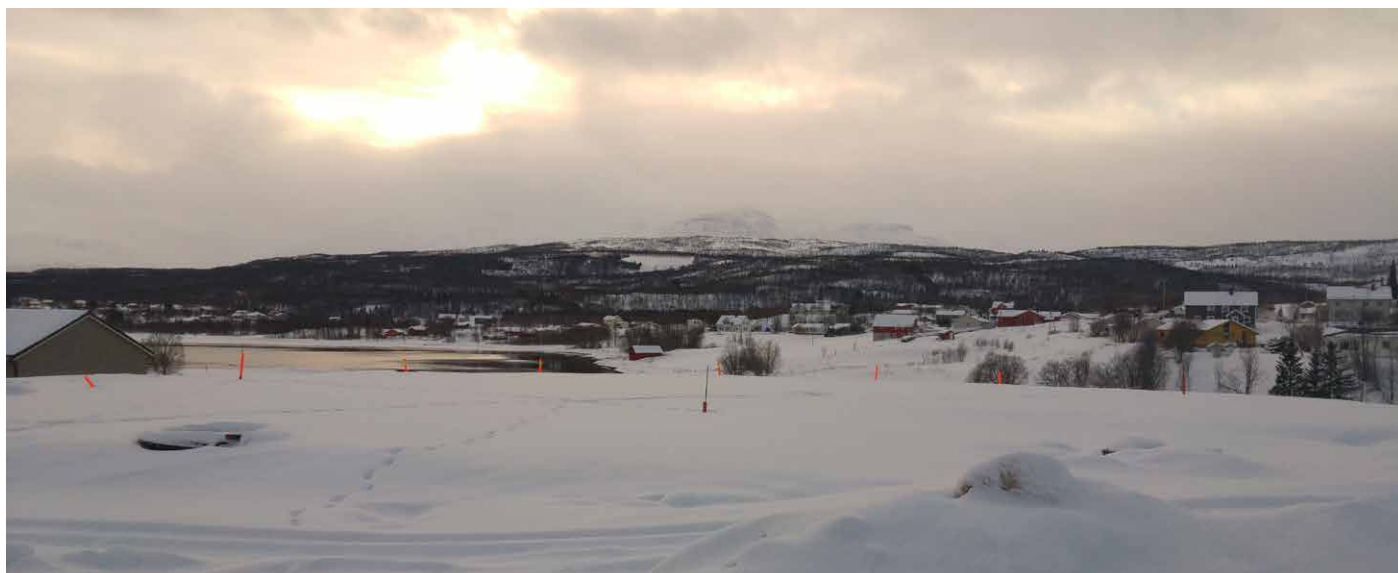
Tomta til den nye Extrabutikken i Sørreisa ligger fint til. Grunnarbeidet er godt i gang.
