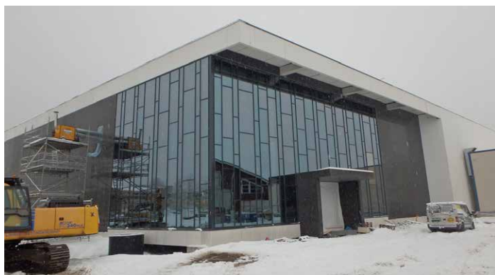
Fasaden og inngangspartiet ved Sjøkanten er nesten ferdig.
