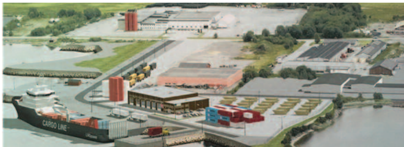
Industrieiendommen i Surnadal.
