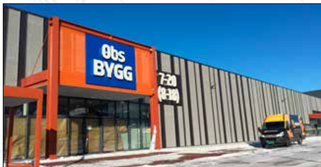
Obs Bygg Narvik to dager før åpningen av butikken.
