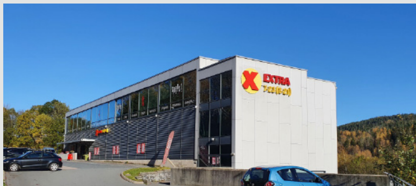
Coop Vestviken signerte kontrakt på kjøp av Lommedalsveien 299 AS i 2020 og overtok denne i 2021.
