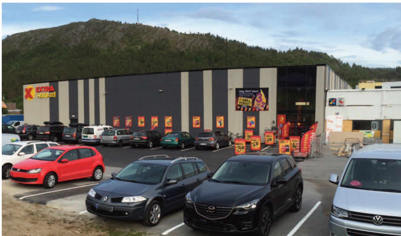
Extra Vatneidet ble nyåpnet i juni 2016. Veggelementene er levert av Kvatro AS.
