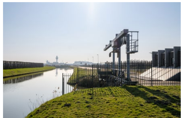
Gemaal NS-Noord aan de noordkant van Schiphol bij P40, het parkeerterrein voor personeel
