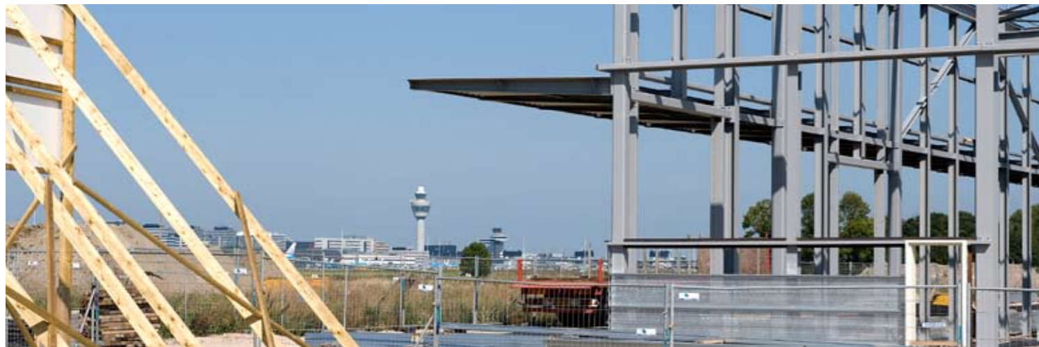
Panalpinagebouw op Schiphol in aanbouw
