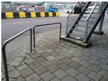
Figuur 4 - Juiste toepassing bij het geleiden van personen bij vluchtwegen
