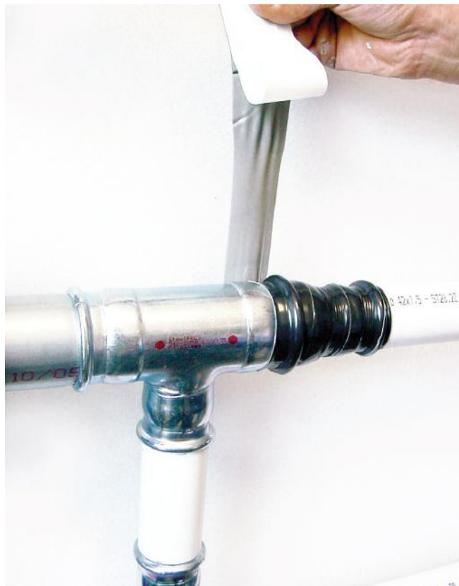
38. attēls — savienotāju aizsardzība ar butanola līmlenti
