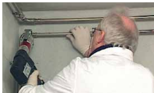
32. attēls - Presējamā savienojuma izgatavošana
