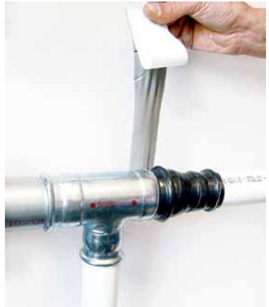
35. attēls - Savienotāju aizsargāšana ar butanola līmlenti
