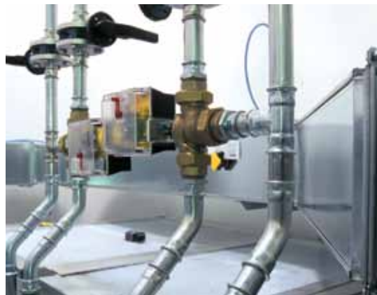
22. attēls - Steelpres - saldēšanas kontūrs
