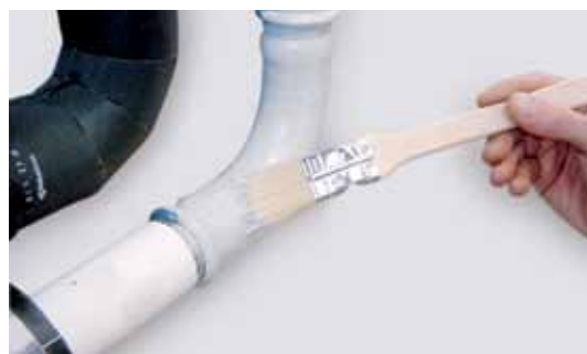
34. attēls - Savienojumu un cauruļu lakošana ar gruntējumu
