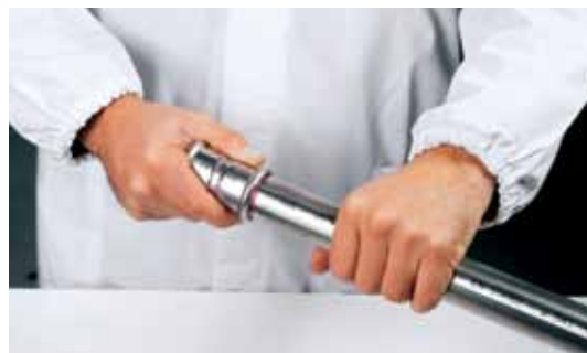
31. attēls - Caurules ievietošana presējamā fittingā
