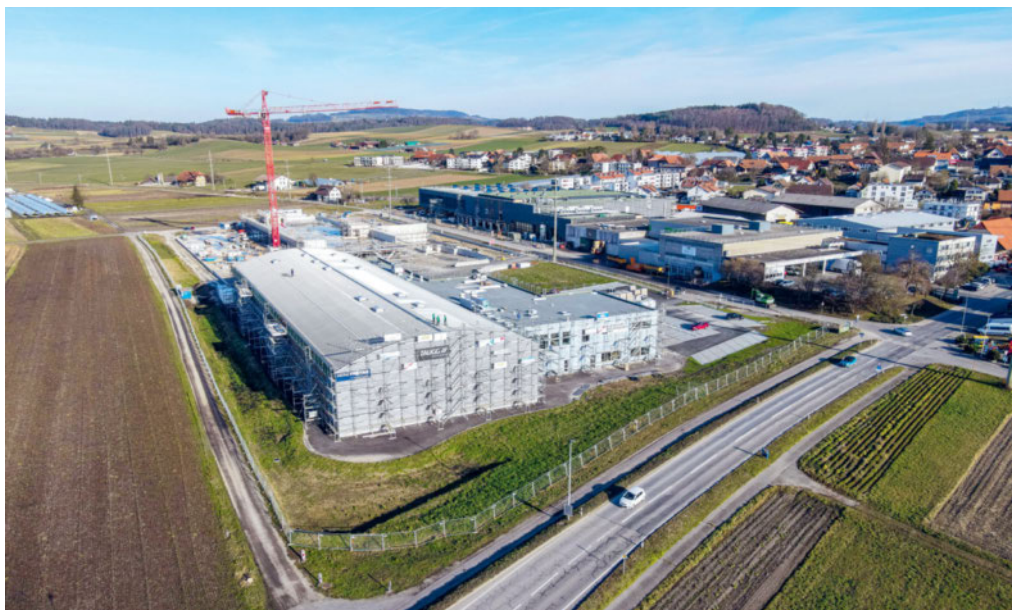
AHP Baustand vom 7. Februar 2024
