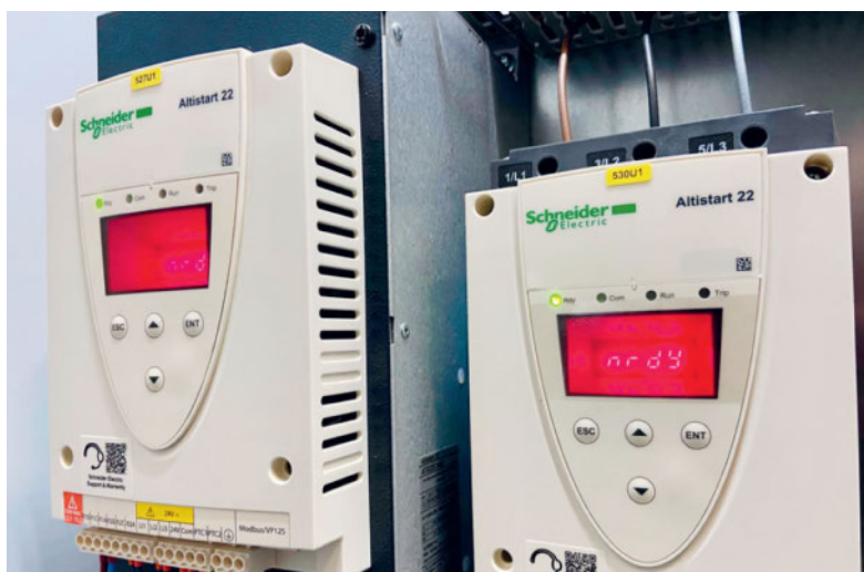
Démarrage progressif pour l'élévateur et le ventilateur du séchoir
