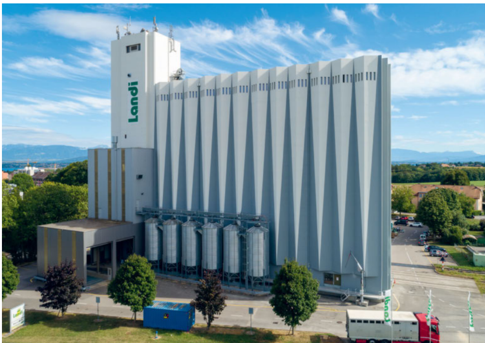
Le silo d'Eysins après assainissement des bétons.
