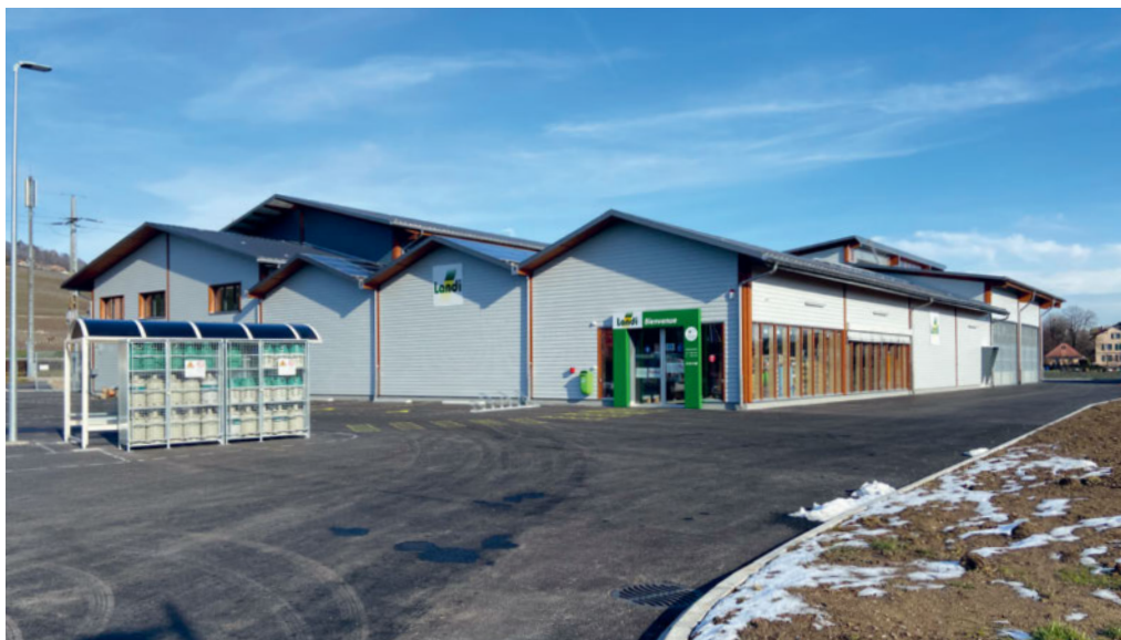
Vue Sud-Ouest du nouveau bâtiment de Perroy
