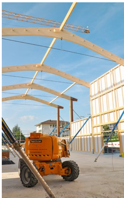
LANDI Cossonay: Montage de la structure bois le 16 août 2017
