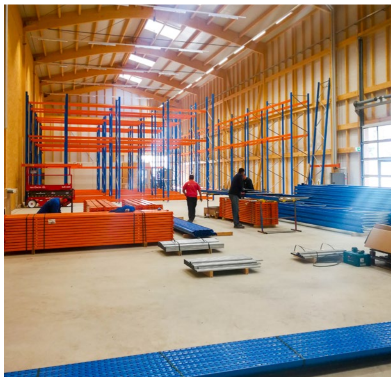
LANDI Cossonay: Montage des racks du dépôt le 1 novembre 2017
