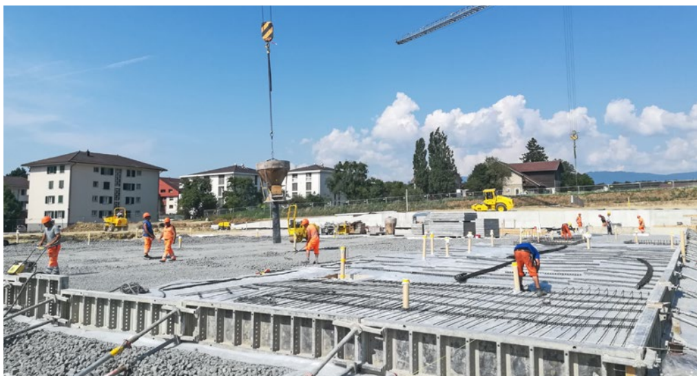
LANDI Cossonay: Préparation de la dalle le 21 juin 2017
