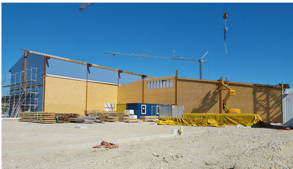
LANDI Cossonay: Montage de la structure bois suite le 21 août 2017
