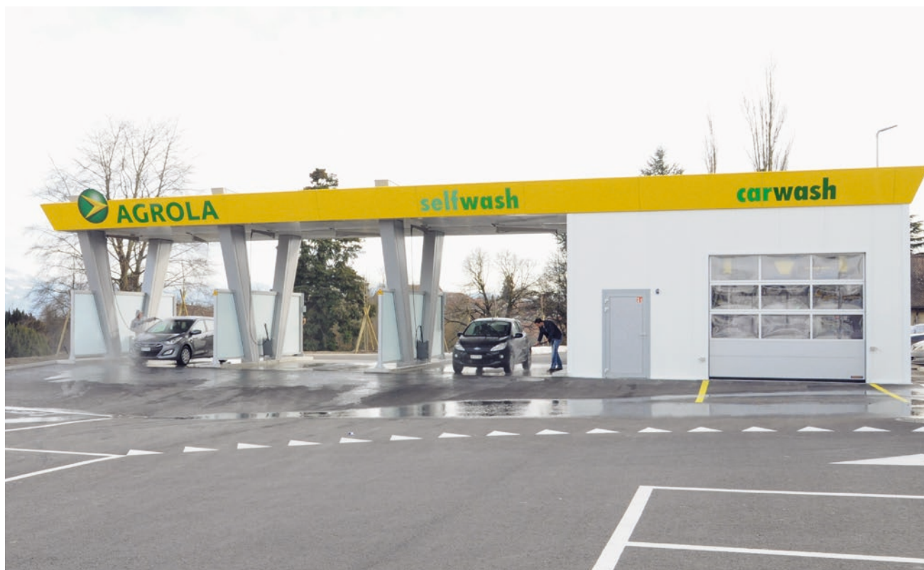
LANDI Cossonay: La station de lavage avec lances, tunnel et aspirateurs
