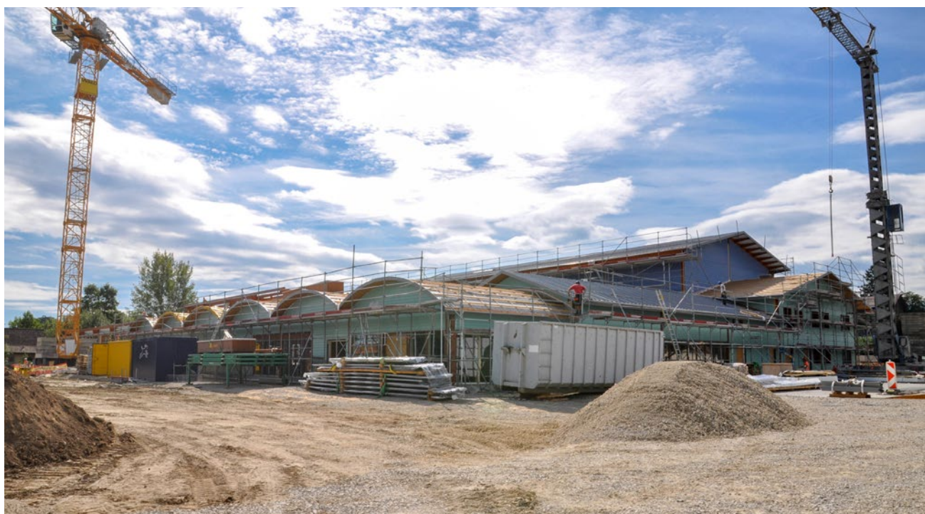
LANDI Cossonay: Finalisation du bâtiment le 4 septembre 2017
