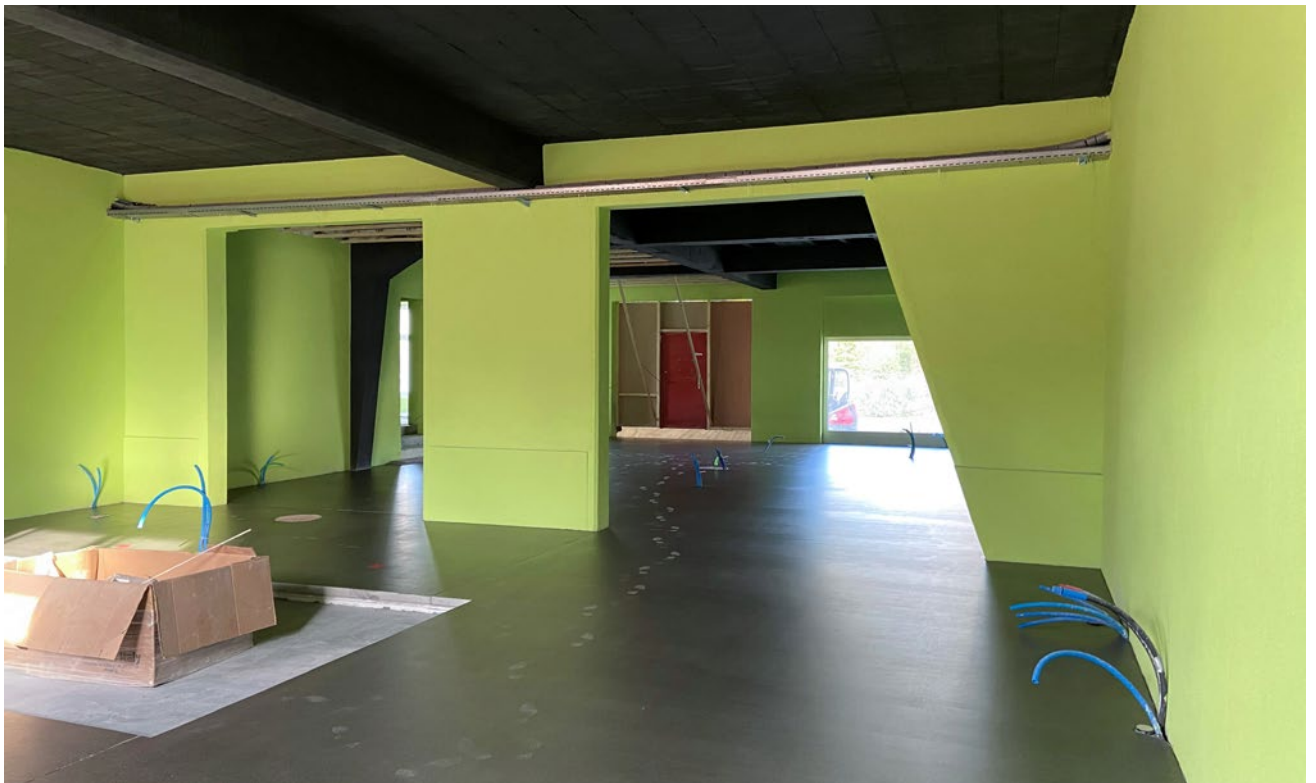
Rénovation intérieur du futur TopShop
