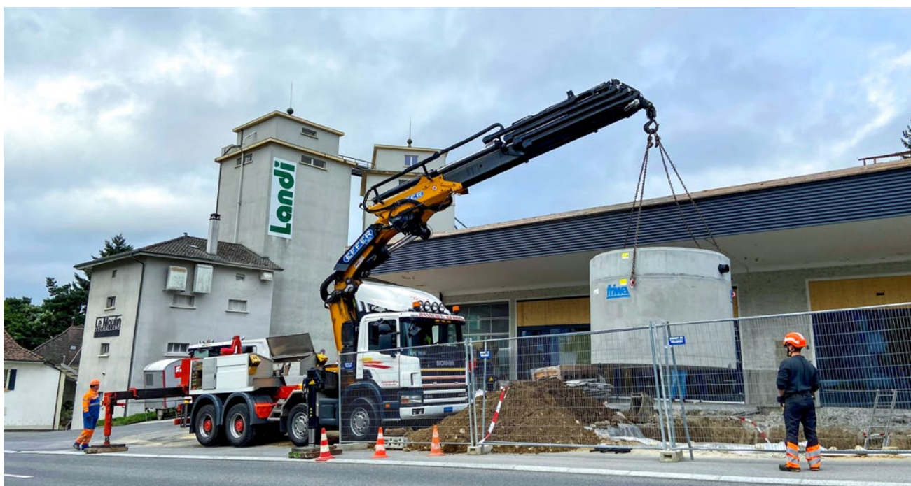
Livraison du nouveau séparateur de la station-service
