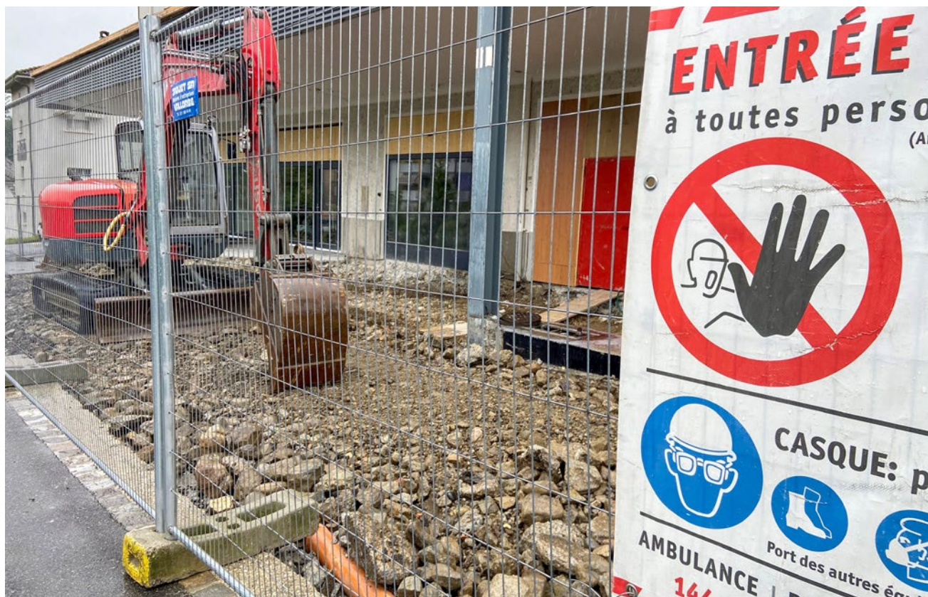
Début de chantier de la future station-service AGROLA avec TopShop
