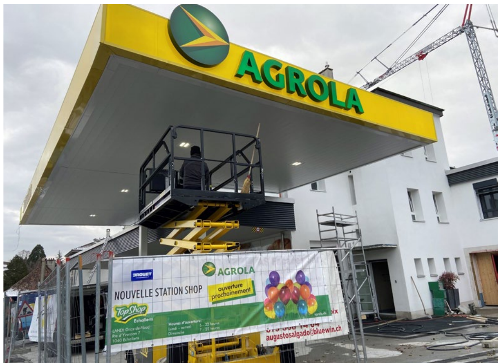
Pose de la nouvelle marquise de la station-service AGROLA
