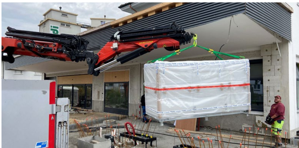
Déchargement du bloc froid des frigos du TopShop
