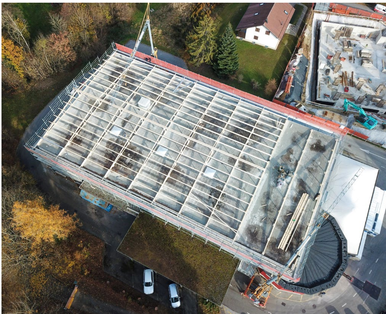
Vue aérienne de la réfection de la toiture de la halle Agro
