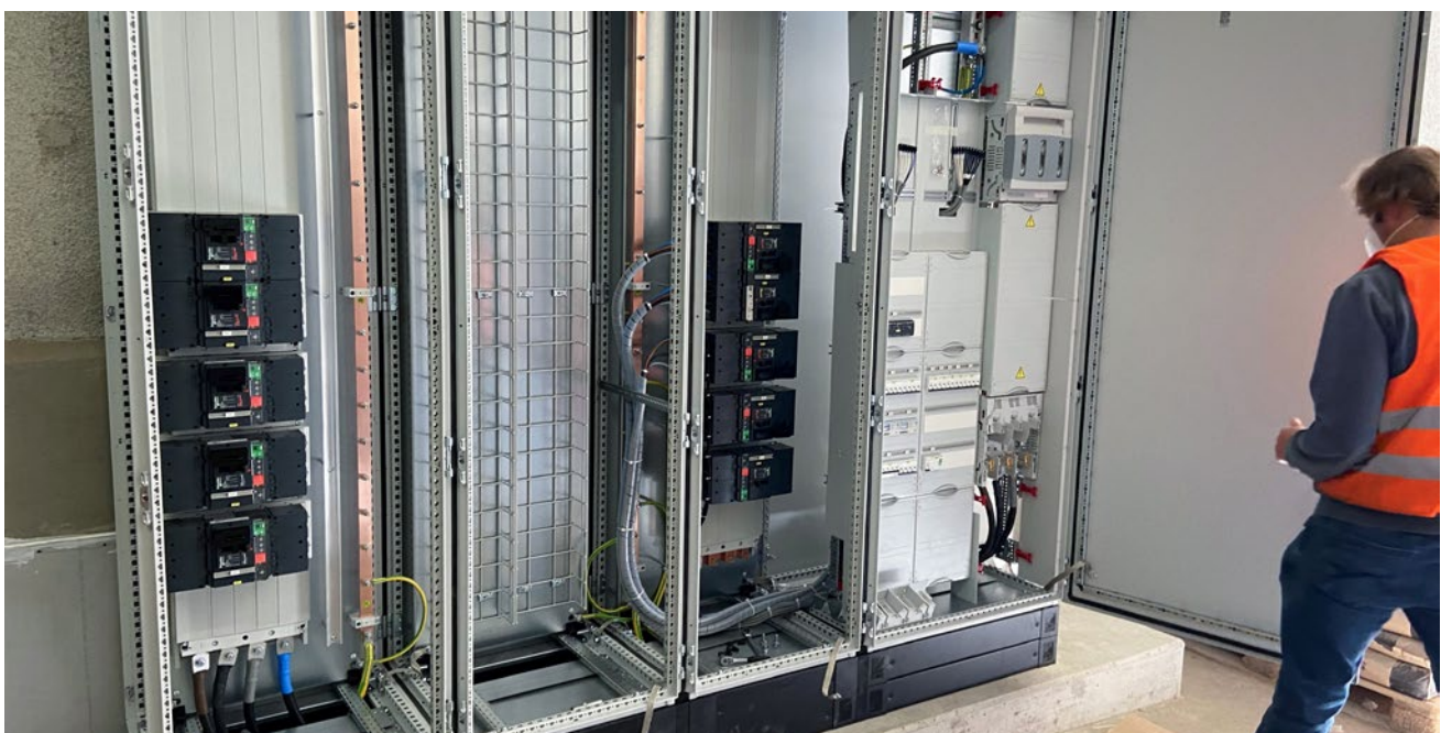
Installation de la nouvelle armoire d'introduction électrique pour la Rte d'Yverdon 5, 7 et 9
