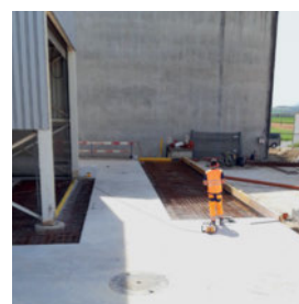
23.4.2019 Les dalles sont terminées
