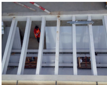
14.5.2019 Pose du fond de la trémie
