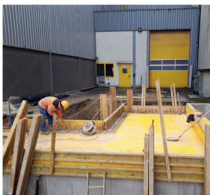
18.3.2019 Coffrage dalle du canal
