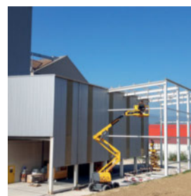
1.5.2019 Début de la construction métallique
