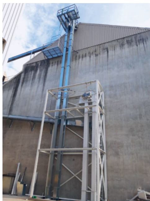
18.6.2019 Les deux nouveaux élévateurs sont montés
