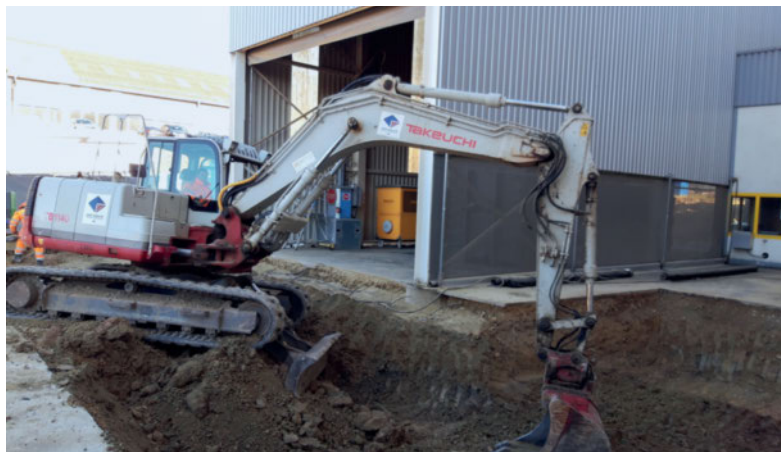
14.2.2019 Creuse du canal transversal
