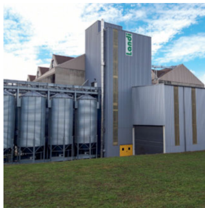
27.1.2019 Le centre collecteur de Chavornay avant travaux
