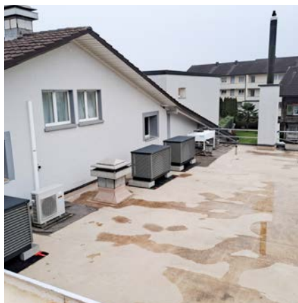
Neuinvestition PV-Anlage +170kWp und Luft/Wärmepumpe
