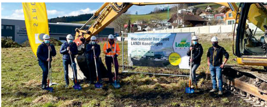
Vertreter der Verwaltung und Geschäftsleitung der LANDI Aare sowie Vertreter der Strüby Konzept AG und der C. Bay AG beim traditionellen Spatenstich. Bild: LANDI Aare
