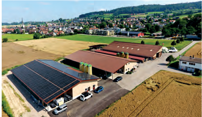
Neue Solaranlage auf dem Betrieb von Ueli Stauffacher, Mettmenstetten
