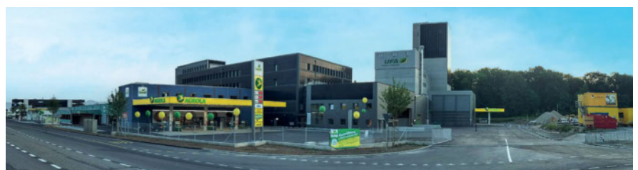
Der neue Standort der LANDI KoWy in Lyssach. Bild: LANDI KoWy
