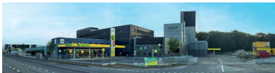
Le nouveau site de LANDI KoWy à Lyssach. Photo: LANDI KoWy
