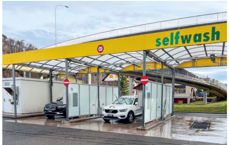
Standort Bauma neue Waschtechnik
