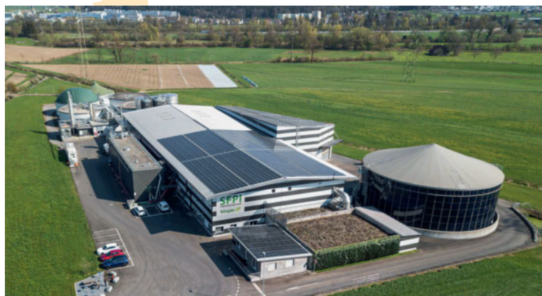
Die Biogasanlage in Inwil verfügt neben den Komponenten wie Nassfermenter, Nachgärer und Verbrennungsmotor auch über Trockenfermenter. Ihre Nachverarbeitung zu drei verschiedenen Recyclingdüngern ist schweizweit einzigartig. Bild: SFPI
