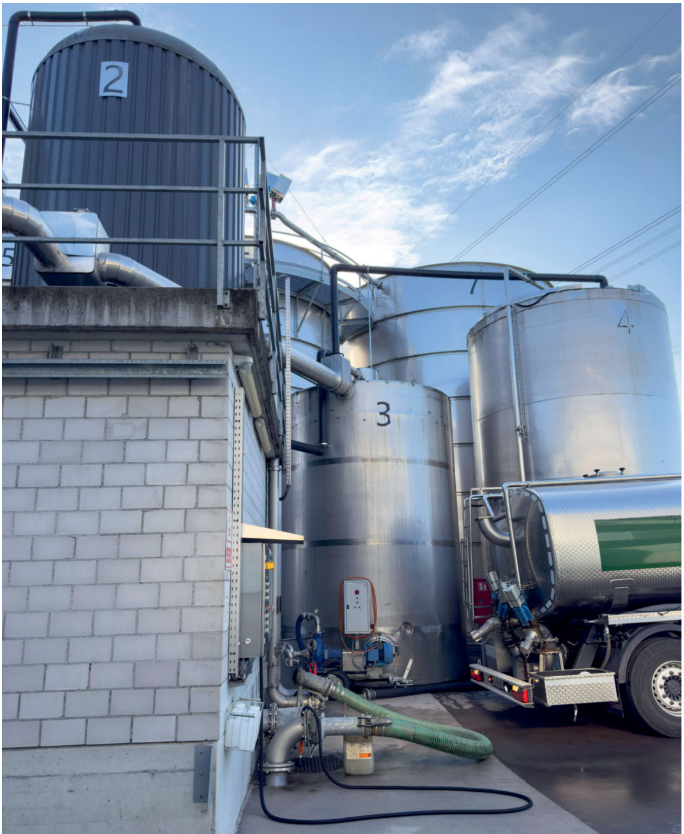
Die industrielle Biogasanlage von Swiss Farmer Power Inwil erhält täglich per Traktor oder durch Bodenleitungen Gülle und andere Biomasse. Daraus produziert sie jährlich 36 000 000 Kilowattstunden Energie und 50 000 Tonnen Recyclingdünger. Dieser kommt dort in die Böden, wo er gebraucht wird. Heute kann die Schweizer Landwirtschaft rund drei Viertel der im Pflanzenbau benötigten Nährstoffe mithilfe von Hofdünger selbst decken.
