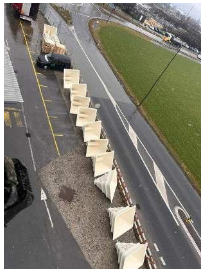
Anlieferung der neuen Trichter für die Silozellen
