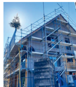
Im September konnten wir in Wagenhausen das Richtfest feiern.
