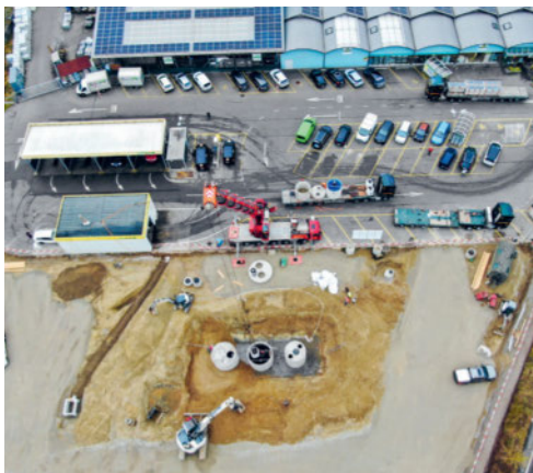
Für diese biologische Wasseraufbereitung wurden bereits zu Beginn der Bauphase drei grosse Betonschächte im Boden versenkt, in denen die Waschwasser-Aufbereitung passiert.
