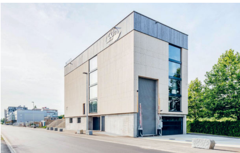
Das Restholz, das bei der Produktion der Holzfassade für die Energiezentrale anfiel, wurde zu Pellets verarbeitet. Bild: Blumer Lehmann AG
