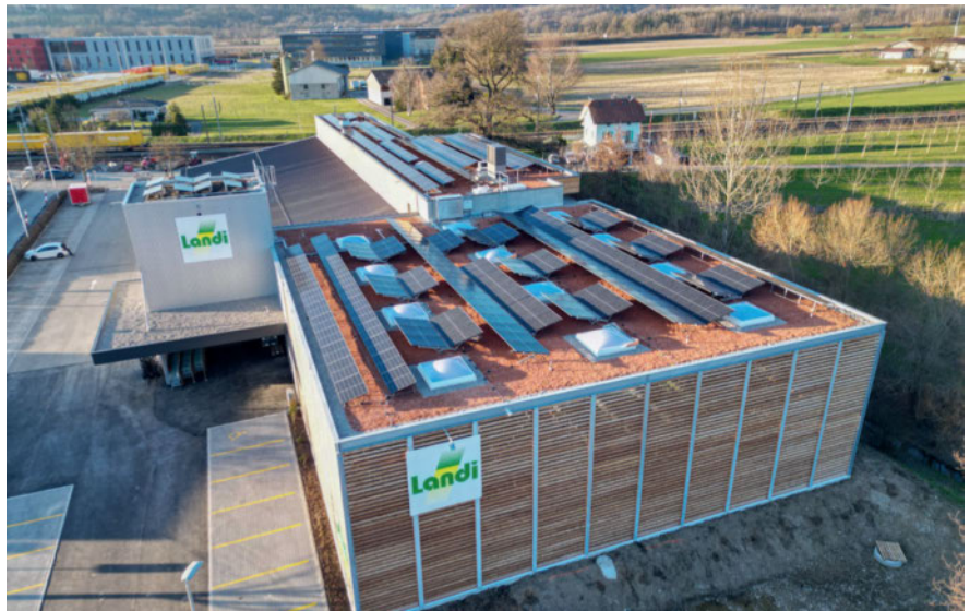
Die Solaranlage der LANDI Thula erzeugt 148 000 Kilowattstunden Strom pro Jahr. Bild: AGROLA
