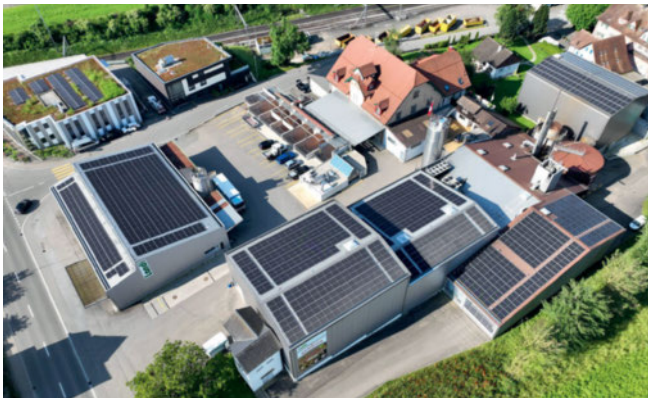
Mit der grossflächigen Solaranlage leisten AGROLA und die LANDI Aachtal einen Beitrag zur Energiewende. Bild: LANDI Aachtal
