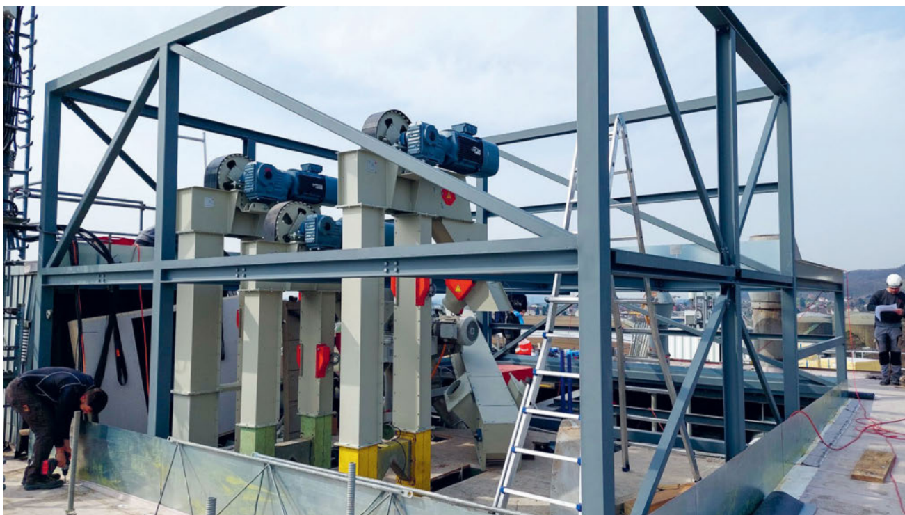
Neuer Dachaufbau beim Silo Oberbipp
