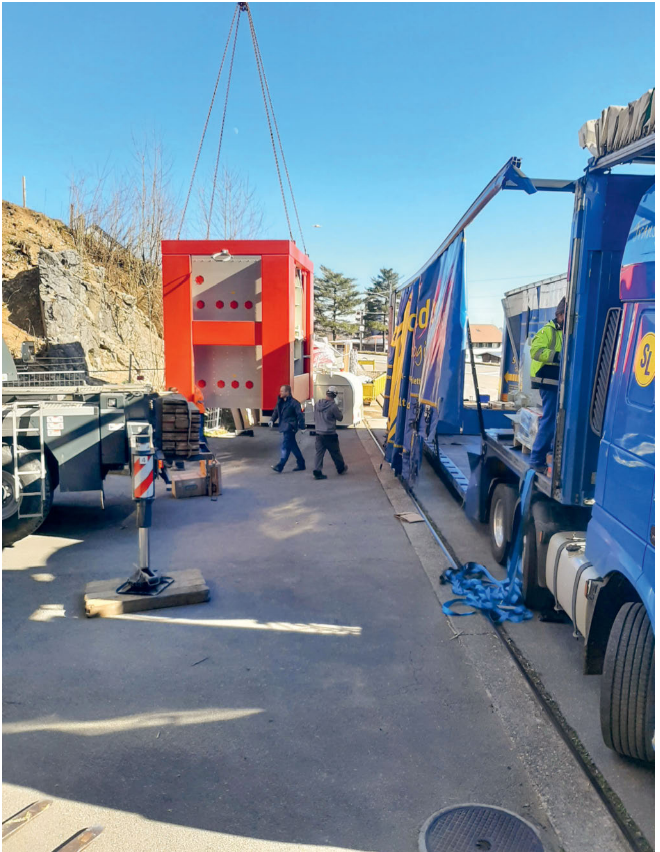
Einbau neuer Reiniger
