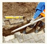
Die Glasfaser wird i. d.R., je nach Untergrundbeschaffenheit, mithilfe der sog. "Erdrakete" mittels Luftdruck unterirdisch zur Hauswand geführt (ca. 15 m pro Stunde). Wir öffnen somit nur einen schmalen Streifen in Ihrer Einfahrt bzw. Vorgarten. Kommen bauliche Alternativen zum Einsatz, besprechen wir diese im Vorfeld mit Ihnen.
