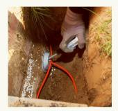
Ein kleines Loch von 16 mm Durchmesser wird in die Hauswand gebohrt und die **Glasfaser durchgeführt**. Anschließend wird das Loch wieder luft- und wasserdicht verschlossen.
