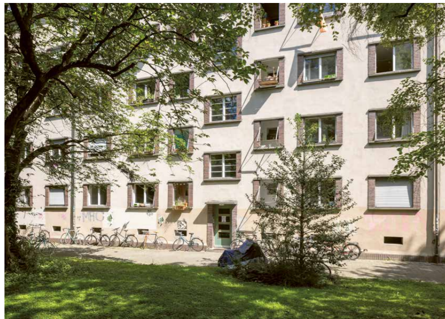
Die Siedlung Seebahn ist zur Zwischennutzung ans Jugendwohnnetz vermietet.
