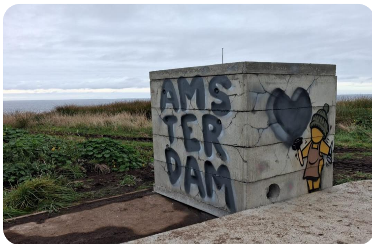
Poste de raccordement en béton préfabriqué installé sur la base de Martin-de-Viviès
