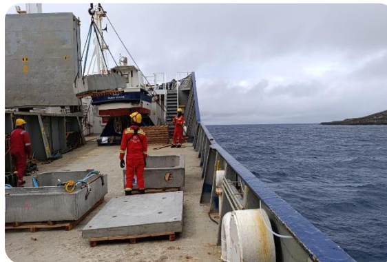
Acheminement des éléments préfabriqués à bord du Marion Dufresne, navire ravitailleur des TAAF
