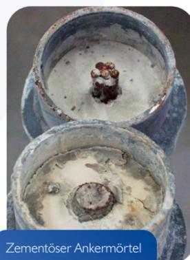
Zementöser Ankermortel mit Korrosionsschutz
