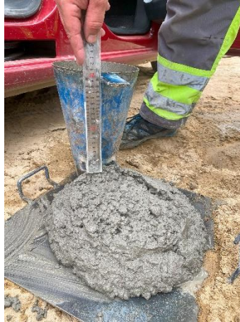
Fot.6 – badanie konsystencji na budowie
