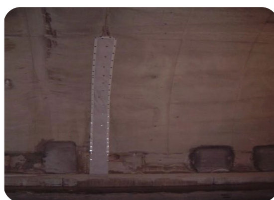
Photos 5 : Géomembrane fixée au moyen de clous Hilti et d'une bande de plastique ou de métal
