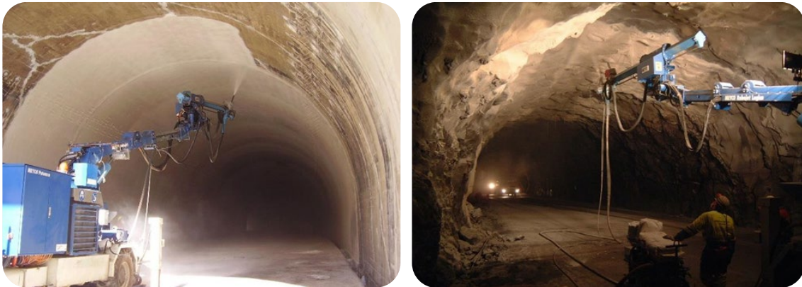
Photos 17 : Application robotique avec le Meyco Logica d'Atlas Copco
