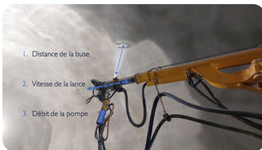
Schéma 18 : Application mécanisée du MasterRoc MSL 345 avec bras robot semi automatique
