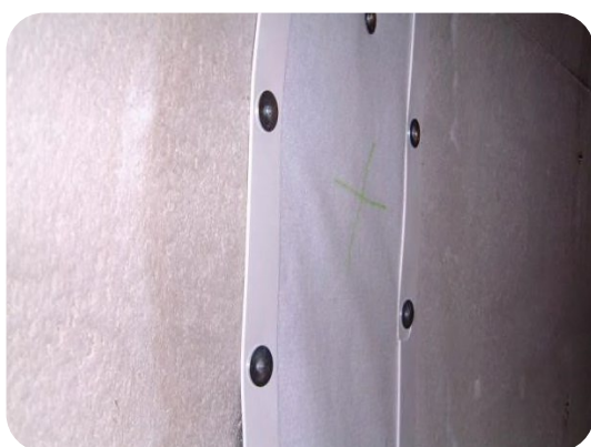
Photos 5 : Géomembrane fixée au moyen de clous Hilti et d'une bande de plastique ou de métal
