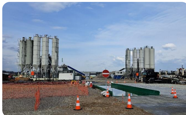
Organisation industrielle du chantier avec centrales de production à forte capacité
