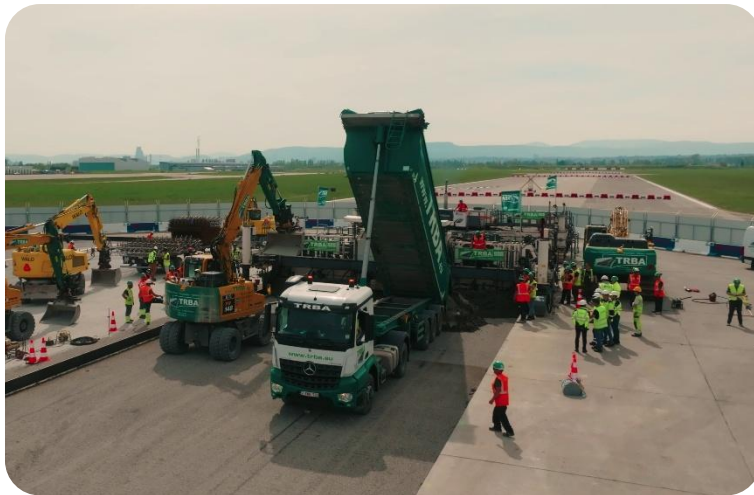
Travaux de réfection de la piste principale
