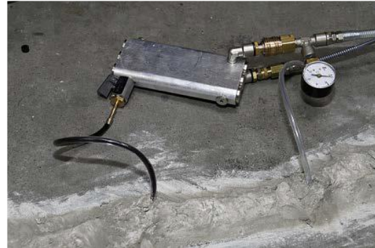
Şekil 3. Beton bir zemini onarmak için 2C pompa kullanılarak MasterFill® I380 enjekte edilmesi.
