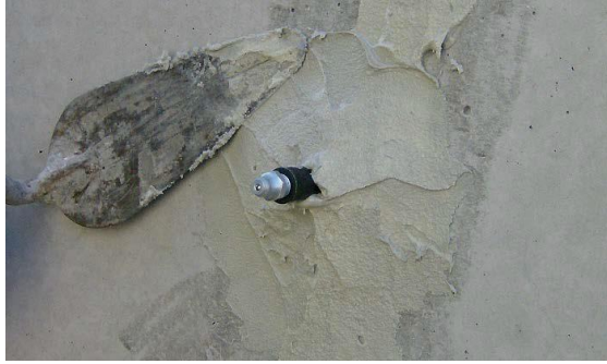
Şekil 2. MasterFlux® ANC 920 SF kullanılarak yüzeye monte nipellerin sızdırmazlığının sağlanması
