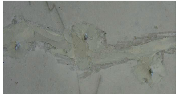
Şekil 1. Soket tipi nipeller çatlakların etrafına yerleştirilir ve MasterStrength™ serisinden uygun epoksi yapıştırıcı ile kapatılır.
