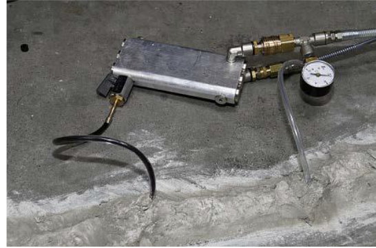
Şekil 3. Beton bir zemini onarmak için 2C pompa kullanılarak MasterFill™ 1380 enjekte edilmesi.
