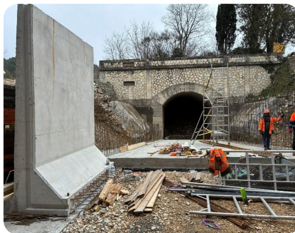
Pose des éléments préfabriqués pour couverture du canal EDF
