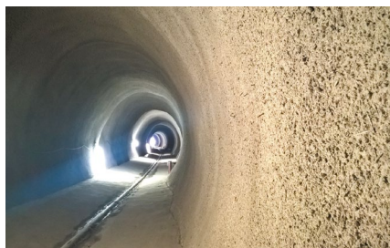
Beton natryskowy z makrowłóknami MasterFiber IS1 SPA na ścianach szybu ewakuacyjnego tunelu Polana.
