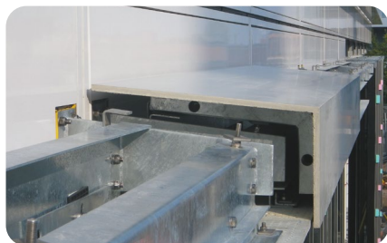
Elementy fasadowe z białego HPC z włóknami MasterFiber 401.
