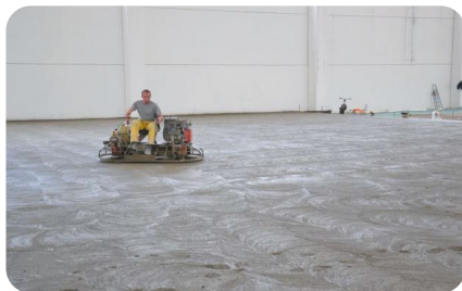
Polerowanie posadzki z makrowłóknami MasterFiber 230.
