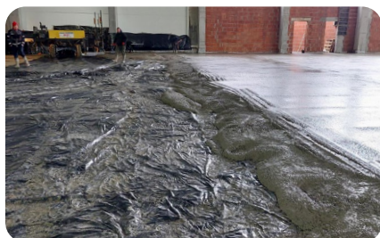
Posadzka przemysłowa z mikrowłóknami MasterFiber 050 w halach magazynów wysokiego składowania
