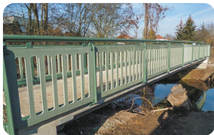
Cienkościenna balustrada z HPC z włóknami MasterFiber 40I.
