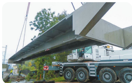
Kładka ze wstępnie sprężonego VHPC z mikrowłóknami MasterFiber 482.
