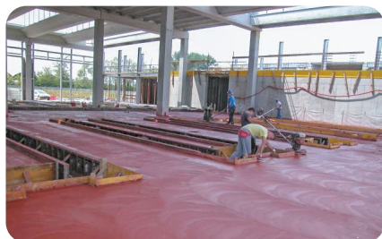
Nawierzchnia na stacji benzynowej z betonu z makrowłóknami MasterFiber 235 SPA.
