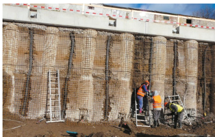
Beton natryskowy z makrowłóknami MasterFiber IS1 SPA na budowie w miejscowości Chomutov w Czechach.
