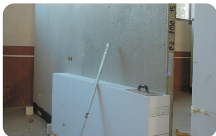
Panele ścienne z makrowłóknami MasterFiber 230.
