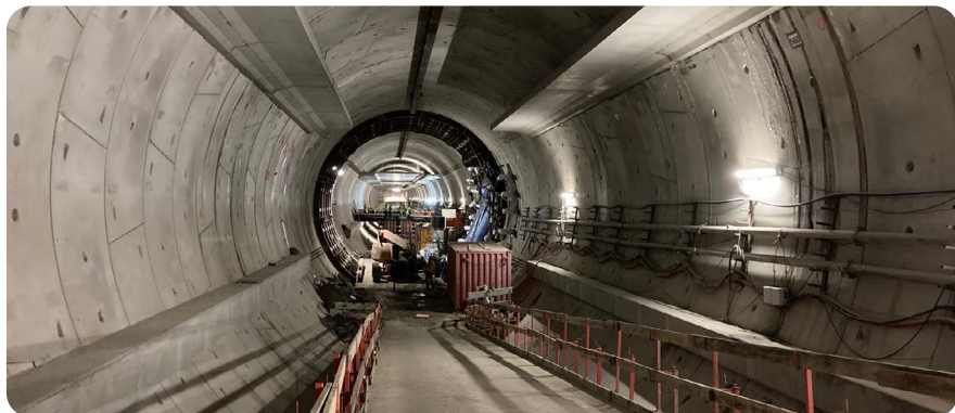
Tunel pod Świną, w którym zostały użyte do tubingów mikrowłókna polipropylenowe MasterFiber 080
