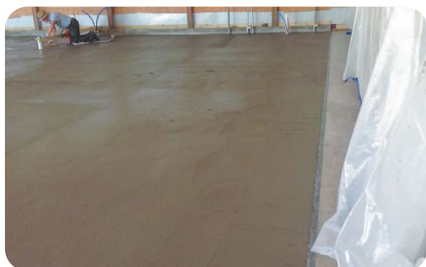
Posadzka przemysłowa z makrowłóknami MasterFiber 235 SPA.
