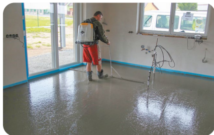
Wylewka samopoziomująca z makrowłóknami MasterFiber 230.
