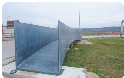
Kładka z cienkościennego VHPC z mikrowłóknami MasterFiber 482.
