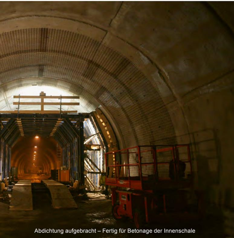
Abdichtung aufgebracht – Fertig für Betonage der Innenschale
