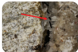
Agrandissement d'une fissure capillaire dans le béton
