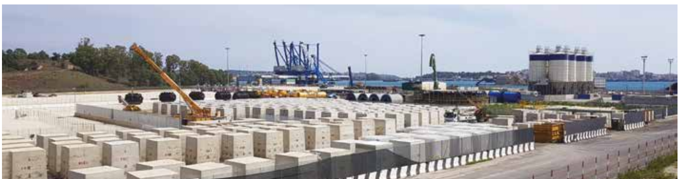
La nostra referenza in Augusta (Italia): lavori di riforimento e ripristino statico della diga foranea del Porto di Augusta in Sicilia.
