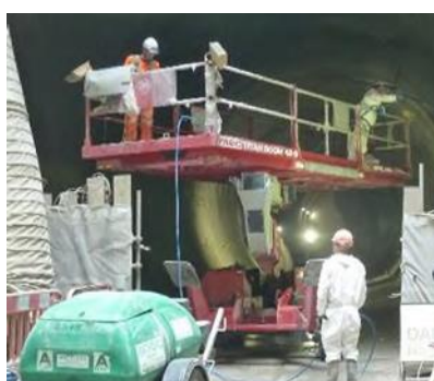
Photo 16 : Plateforme de projection appropriée
