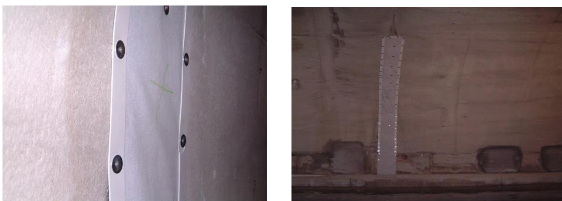
Photos 5 : Géomembrane fixée au moyen de clous Hilti et d'une bande de plastique ou de métal
