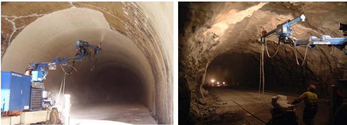
Photo 17 : Application robotique avec le Meyco Logica d'Atlas Copco
