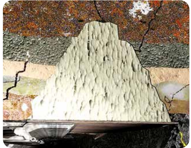
Fylling av hulrom med MasterRoc® MP 367 Foam
