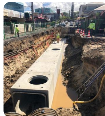
Positionnement des dalots à Saint Pierre par grue mobile
