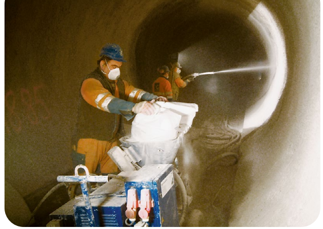
Aufgabe des in Säcken von 15 kg angelieferten MasterRoc® MSL 345 in die Trockenspritzmaschine, z.B. MEYCO Piccola.
