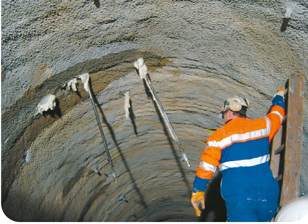
Temporäres Stoppen von stärkeren Wasserzutritten mittels PU-Injektionen.
